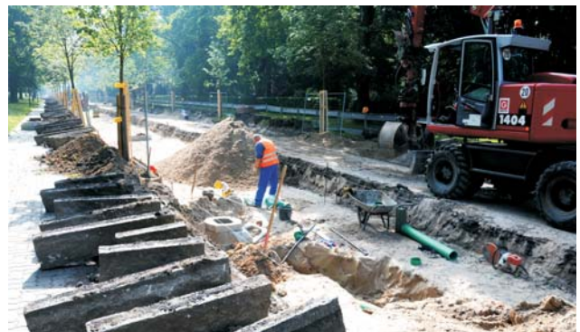
Sanierungsmaßnahmen der Straßen und Siele in der Sorbusallee.
